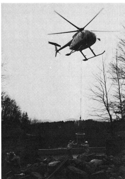
Abb.3 Wildenburg ZG: Materialtransporte mit Hilfe eines Helikopters.
