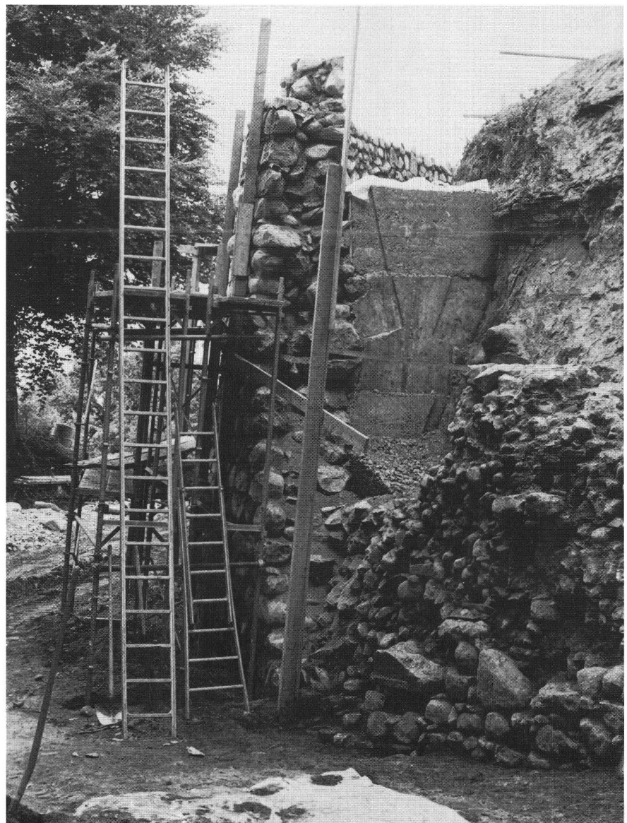
Abb.8 Lieli LU: Die Grabenfurtermauer wurde in diesem Bereich vollständig neu aufgeführt. Der Betonpfeiler hinter der Mauer dient zum Auffangen des Hangdruckes.
