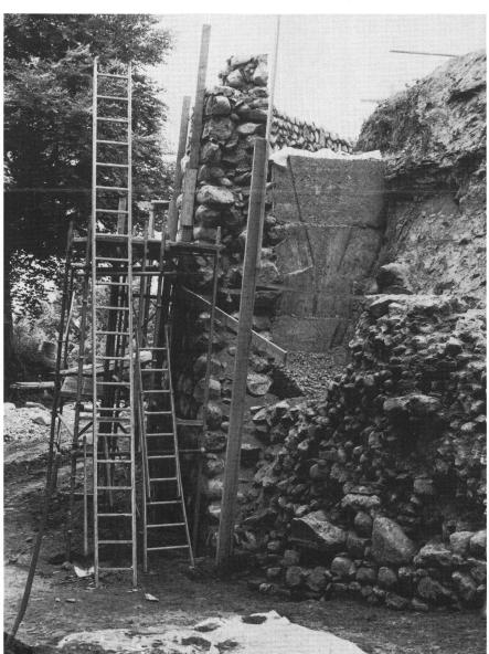
Abb.8 Lieli LU: Die Grabenfuttermauer wurde in diesem Bereich vollständig neu aufgeführt. Der Betonpfeiler hinter der Mauer dient zum Auffangen des Hangdruckes.
