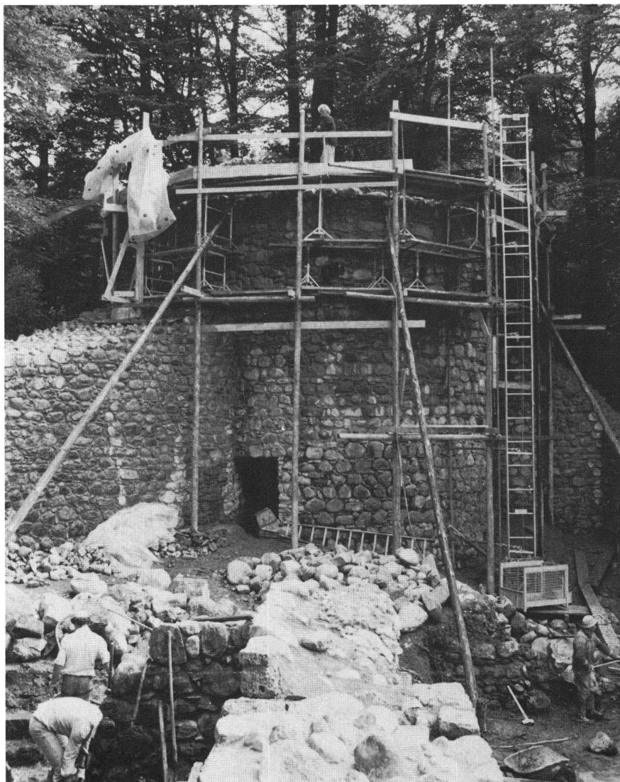
Abb.4 Wildenburg ZG: Der eingestützte Rundturm der Ruine während der Konservierung.
