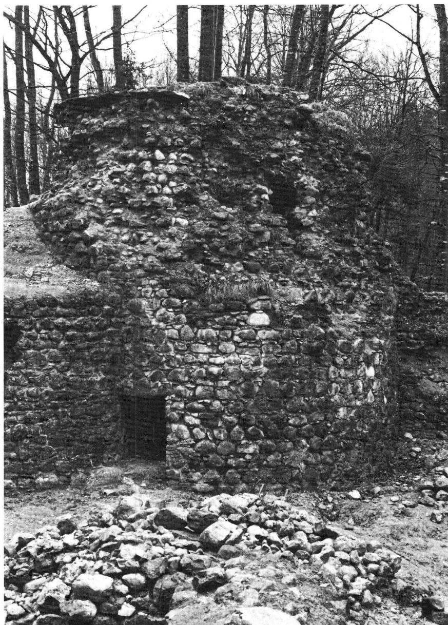
Abb. 2 Wildenburg ZG: Der Rundturm der Ruine vor der Konservierung.
