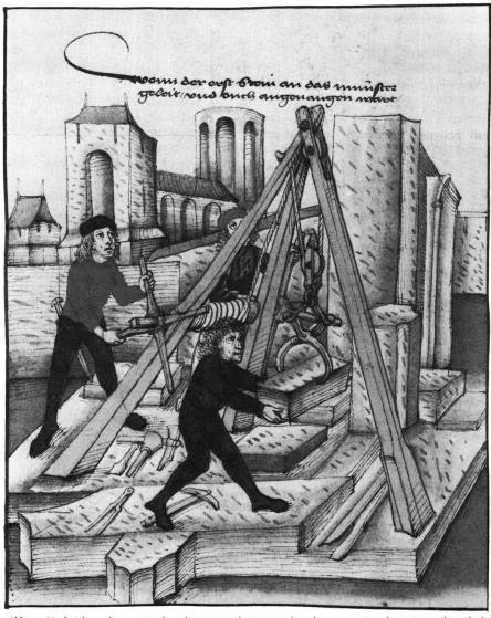
Abb. 1 Hochziehen schwerer Werkstücke mit Dreibein, Haspel und Zange. (Aus der Spiezer Chronik des Diebold Schilling)
