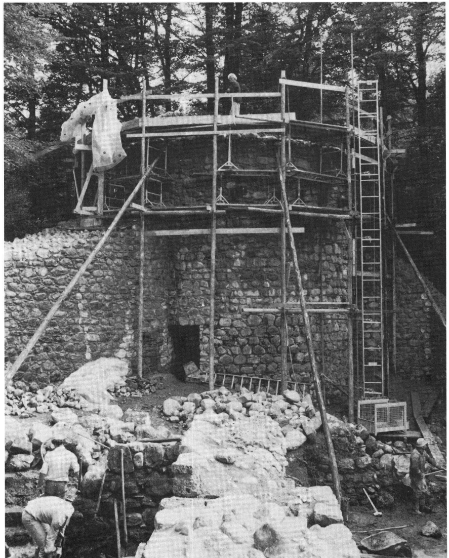
Abb.4 Wildenburg ZG: Der eingestützte Rundturm der Ruine während der Konservierung.
