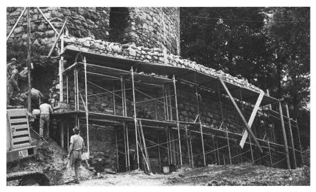
Abb. 7 Lieli LU: Arbeiten an der Grabenfuttermauer. Man beachte das massive Gerüst, das bei Arbeiten mit Bruchsteinen benötigt wird.
