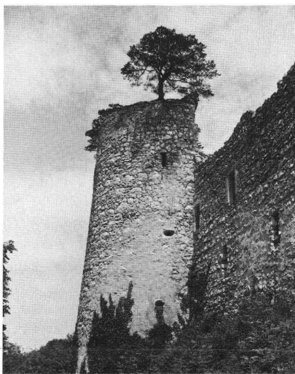
Dorneck SO. Der mächtige Baum auf der Turmkrone setzt bei Windstössen Mauermassen von mehreren Kubikmetern Inhalt in Bewegung und bewirkt so die allmähliche Zersetzung des Mauergefüges.
