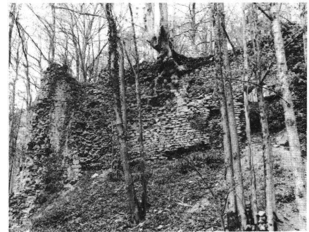
Montvoie JU. Die einsam gelegene Ruine wird vom Wald hart bedrängt. Der mächtige Wurzelstock in der Bildmitte hat grosse Teile des Mauergefüges bereits gesprengt.
