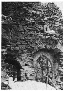
Wieladingen BRD. Der von oben her durch Wurzelwerk zersetzte Torbau ist kurz nach dieser Aufnahme eingestürzt.
