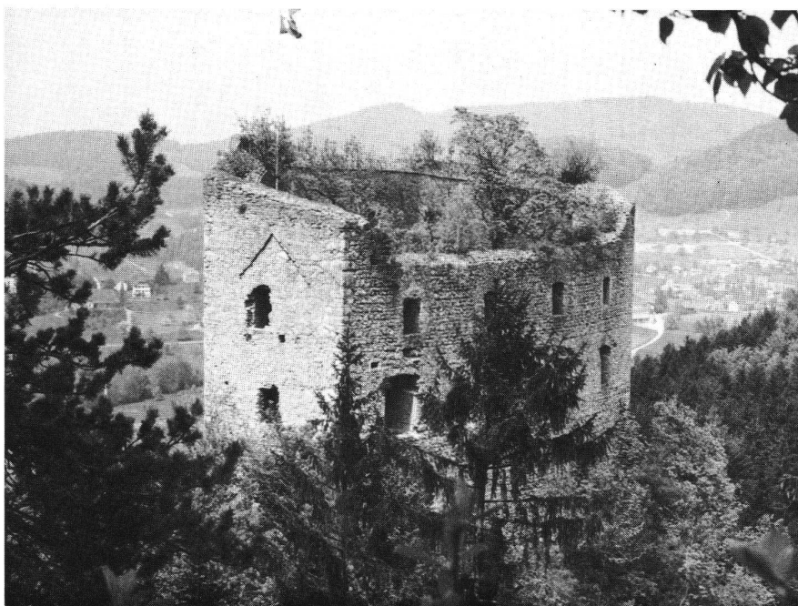
Gilgenberg SO. Üppiger Strauch- und Baumbewuchs machten rund fünfzig Jahre nach der ersten Konservierung eine aufwendige Zweitrestaurierung notwendig.
