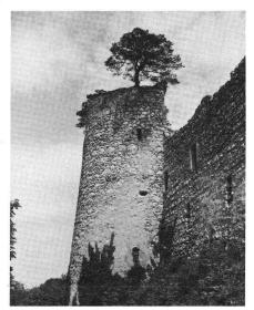
Dorneck SO. Der mächtige Baum auf der Turmkrone setzt bei Windstössen Mauermassen von mehreren Kubikmetern Inhalt in Bewegung und bewirkt so die allmähliche Zersetzung des Mauergefüges.
