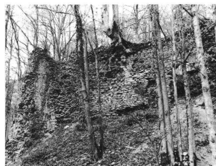
Montvoie JU. Die einsam gelegene Ruine wird vom Wald hart bedrängt. Der mächtige Wurzelstock in der Bildmitte hat grosse Teile des Mauergefüges bereits gesprengt.
