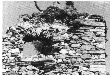
Splügen GR. Schwere Schäden im Kronenbereich, verursacht durch das Wurzelwerk einer mittlerweile abgestorbenen Föhre. Man beachte, wie der oberste Eckstein durch den Wurzeldruck aus seiner ursprünglichen Lage geschoben worden ist.
