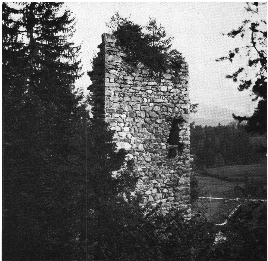
Grüneck GR. Auflösung des Mauerwerks von oben her infolge Baumwuchses auf der Mauerkrone.
