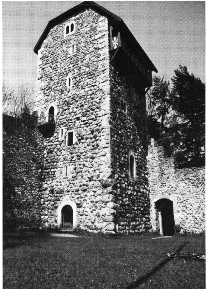
Iberg SG. Blick von E auf den noch sechs Stockwerke hohen Bergfried.
