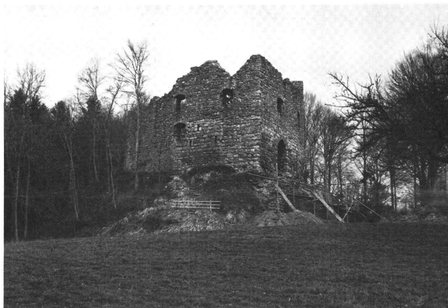
Abb. 2, Ansicht der Ruine von SW mit der eingestützten Mauer M2.
