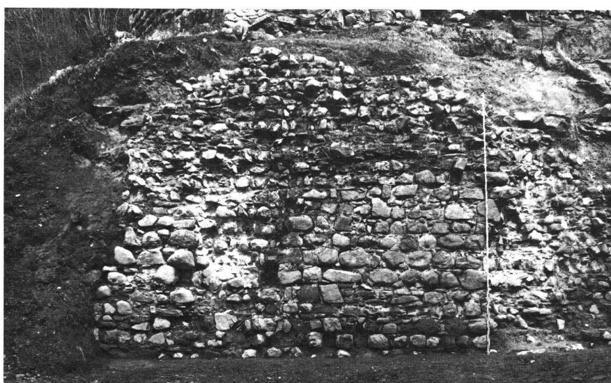
Abb. 6, Detail der Mauer M2. Gut sichtbar ist das lagerhaft aufgeführte Mauerbaup.
