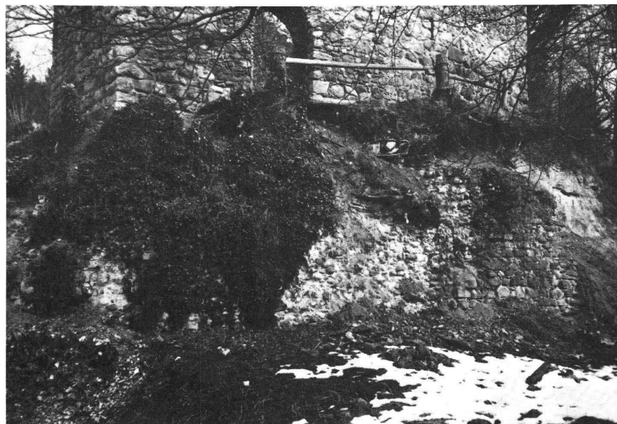
Abb. 3, Die Futtermauer M2 vor der Freilegung.
