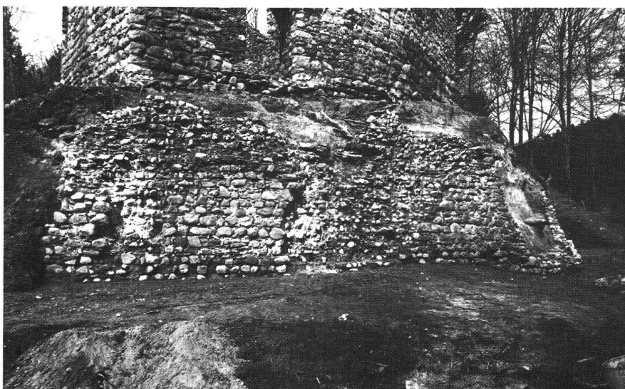
Abb. 5, Die Futtermauer M2 nach der Freilegung.
