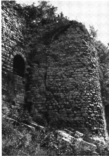
Vorder-Wartenberg BL. Das heutige Mauerwerk reicht nicht weiter als bis ins 12. Jahrhundert zurück. Die Bodenfunde datieren die Anfänge der Anlage in die Karolingerzeit (9. Jahrhundert).
