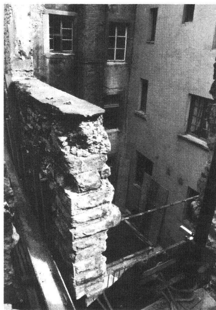
Abb. 2, Nordwestecke des Wohnturms.
