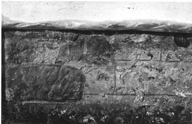
Südostecke an der Ostfassade: Die Kellenstriche des Verputzes wurden in die roten Linien integriert.
