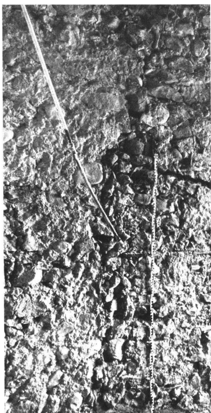
Kappel, «Einsiedlerhaus»: Eckverband. Gleiche Steinsetzungen und «Backenformen».
