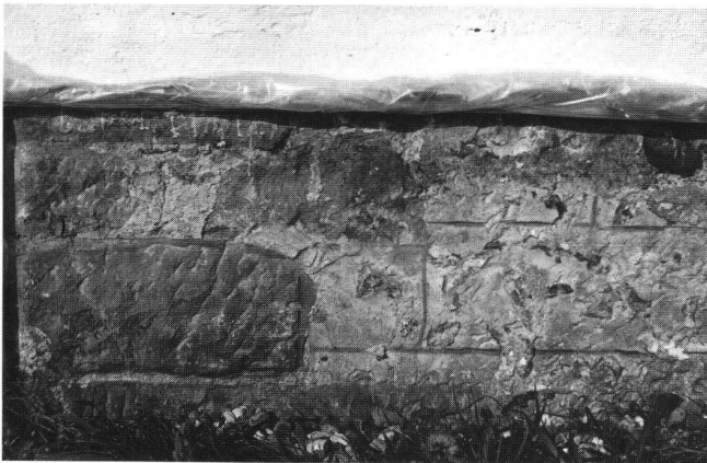
Südostecke an der Ostfassade: Die Kellenstriche des Verputzes wurden in die roten Linien integriert.
