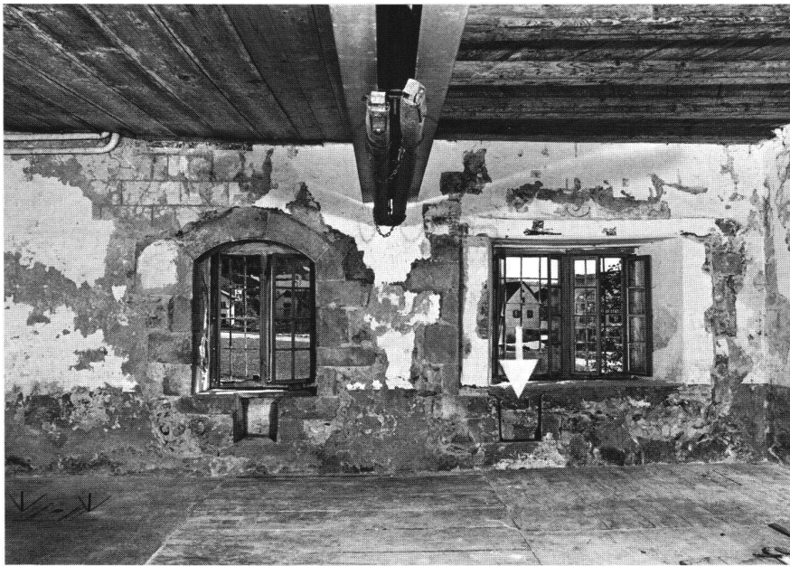
Ostwand des Ostraumes im Obergeschoss des ehem. «Einsiedlerhauses». Das Bild zeigt die beiden Sitznischenfenster (-spuren) mit dem vorstehenden Verputz mit roter Quaderung.
