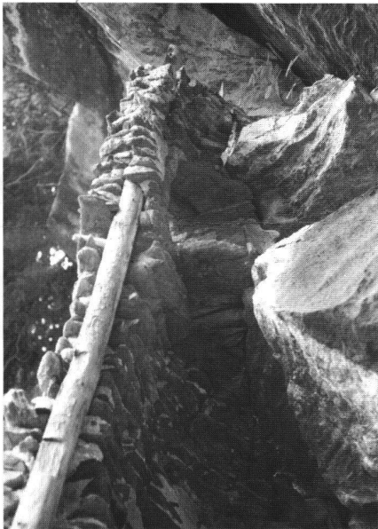
Abb. 7 Hérémence VS, grotte aux fées. Die dünne, gekrümmte Wand des oberen Baues ist um die Holzarmierung herum aufgemauert. Als der Bau teilweise einstürzte, riss das Mauerwerk an der durch das Holz geschwächten Stelle.
