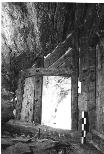
Abb.8 Hérémente VS, grotte aux fées. Verputzter hölzerner Bau, Innenansicht der Türwand. Rechts die Talseite. Der erste und vierte Ständer von links stecken mit ihren Köpfen in ausgemeisselten Vertiefungen des Felsdaches.
