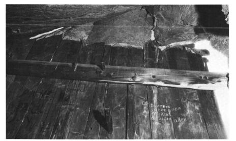
Abb. 10 Hérémence VS, grotte aux fées. Verputzter hölzerner Bau, Innenansicht der talseitigen Wand und des Steinplattendaches. Die dritte Wandbohle von rechts ragt über das Dach hinaus, wo sie in einer Felsspalte verkeilt ist.
