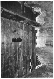
Abb. 9 Hérémence VS, grotte aux fées. Verputzter hölzerner Bau, Innenansicht der talseitigen Wand. Am hinteren Felsanschluss waren zwei Licht- und Beobachtungsöffnungen ausgespart. Auf halber Höhe eine Holzkonsole unbekannter Zweckbestimmung.
