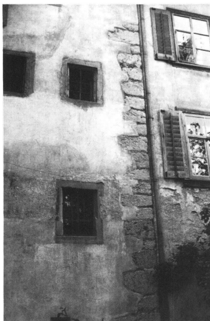
Winkelriedhaus Stans NW, Eckverband des mittelalterlichen Wohnturmes (Fotoarchiv SBV)
