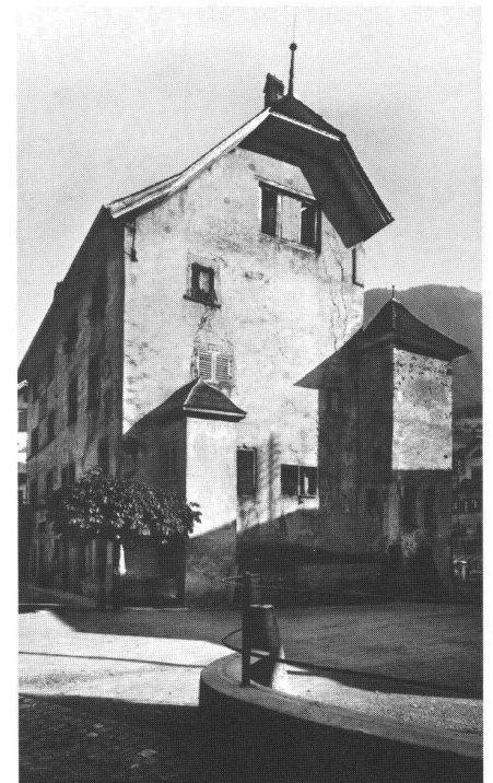
Rosenburg Stans NW, Aufnahme um 1930, vor der Restaurierung (Fotoarchiv SBV)
