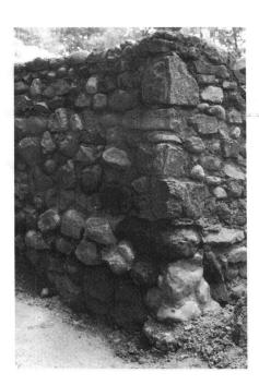
Beispiel für die unglückliche Zweitverwendung eines Bossenquaders als Eckstein bei den Konservierungen von 1961/62. Nordwestecke der Umfassungmauer.
