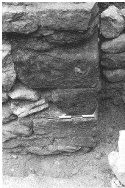
Eckverband an der östlichen Ecke des Viereckturmes.
