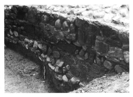
Schnitt 55: Maueransicht der südlichen Umfassungsmauer. Im oberen Teil ist deutlich die ausgefüllte Bresche im Aussenmantel sichtbar. Der Massstab gibt die westliche Begrenzung des ausgefüllten Grabens an. Gut sichtbar ist die Ausbuchtung der Mauer in den Graben.
