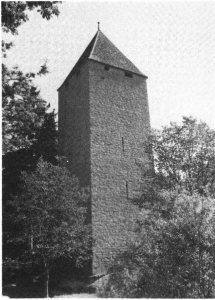
La Molière FR, Hauptturm
