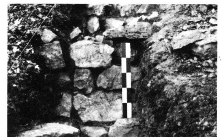
Riedflue, Umfassungsmauer M 2, Ansicht Aussenseite
