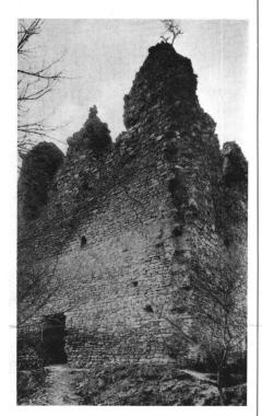
Mittlerer Wartenberg. Zustand um 1920. Das originale Mauerwerk ist heute durch zu weit getriebene Restaurierungsmassnahmen verpflastert
