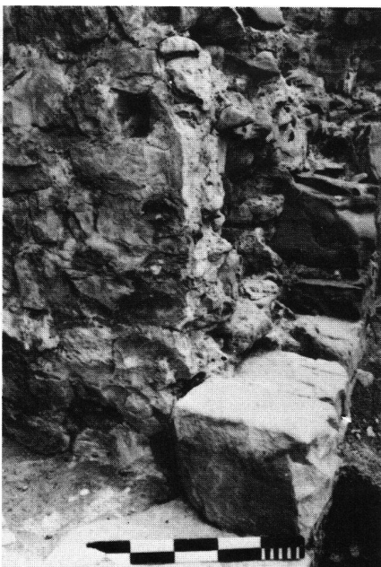
Seedorf, Eingang in den Burgturm mit Gewandstein und Kanal für den Sperr-Riegel
