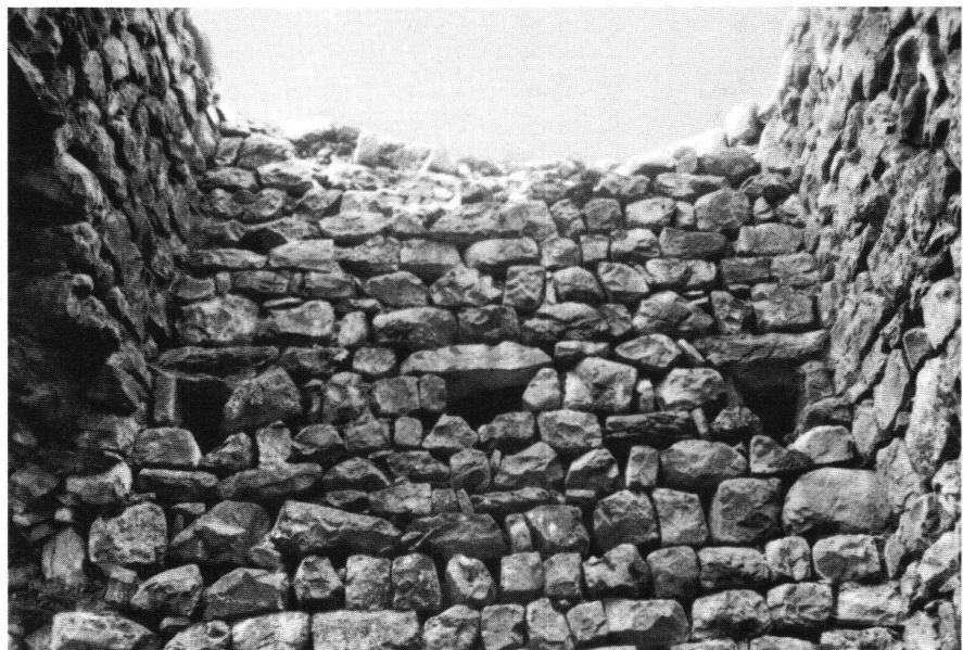
Seedorf, Burgturm, Inneres mit Balkenlöchern in der Südostwand
