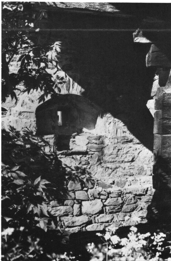
Abb. 3, Innenseite der Nordmauer des Hauses von Winkelmaten. Eine der «Schiessscharten» mündete in eine schön gemauerte Nische mit Stichbogen und Küchenausguss.
