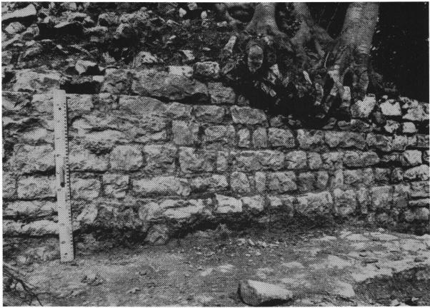
Abb. 2. Lagerhaftes Quadermauerwerk am Aussenmantel der Schildmauer.
