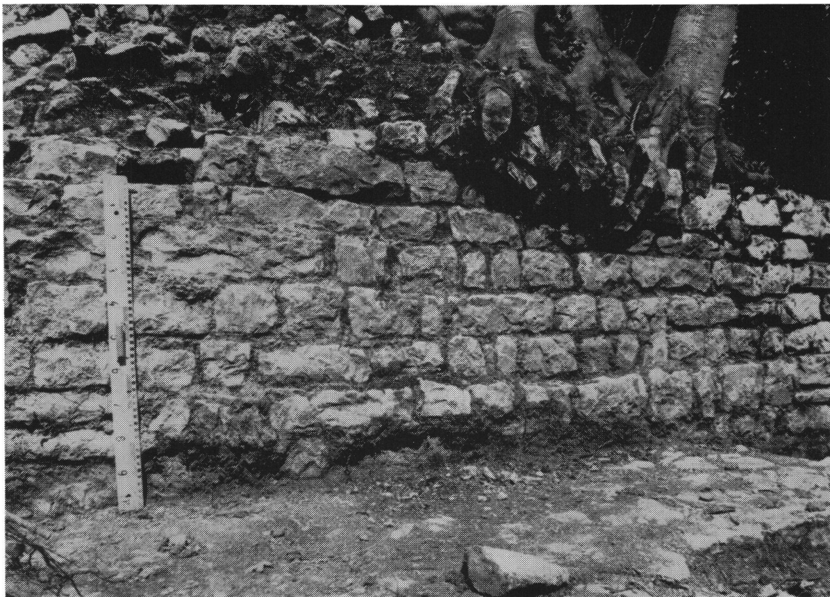
Abb. 2. Lagerhaftes Quadermauerwerk am Aussenmantel der Schildmauer.
