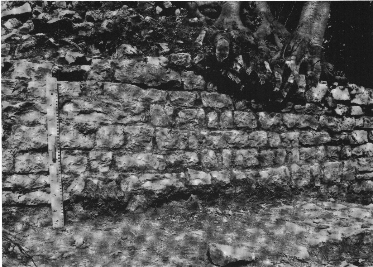
Abb. 2. Lagerhaftes Quadermauerwerk am Aussenmantel der Schildmauer.
