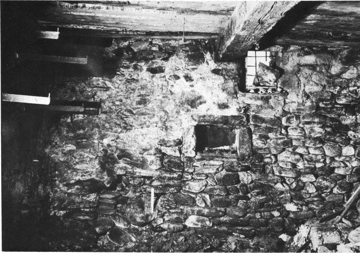
Salzhof in Brig VS. Ringmauer M 14, Innenmantel.
