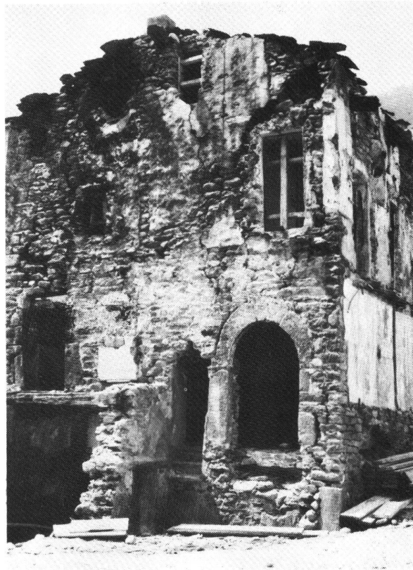
Salzhof in Brig VS. Ansicht des Wohnturmes (Bau A) von SE.
