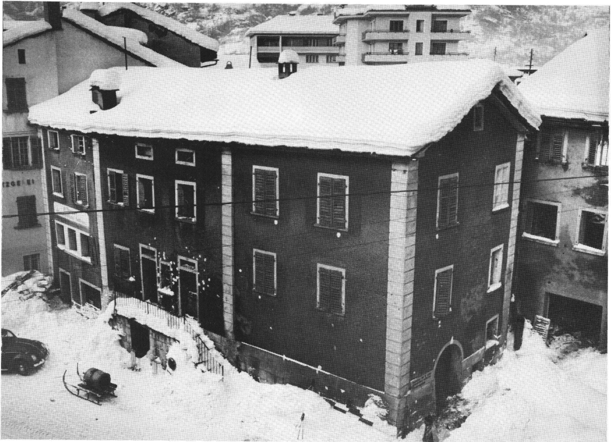
Salzhof in Brig VS vor Beginn des Abbruchs 1968. Ansicht von SW.
