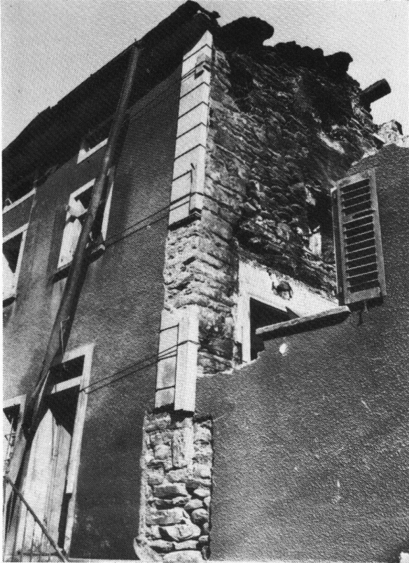
Salzhof in Brig VS. SW-Ecke des Turmes mit abweigendem Bering M 3 während des Abbruchs 1970.
