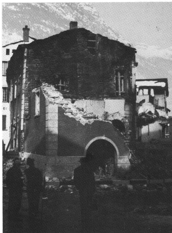
Salzhof in Brig VS, Wohnturm während des Abbruchs 1970.
