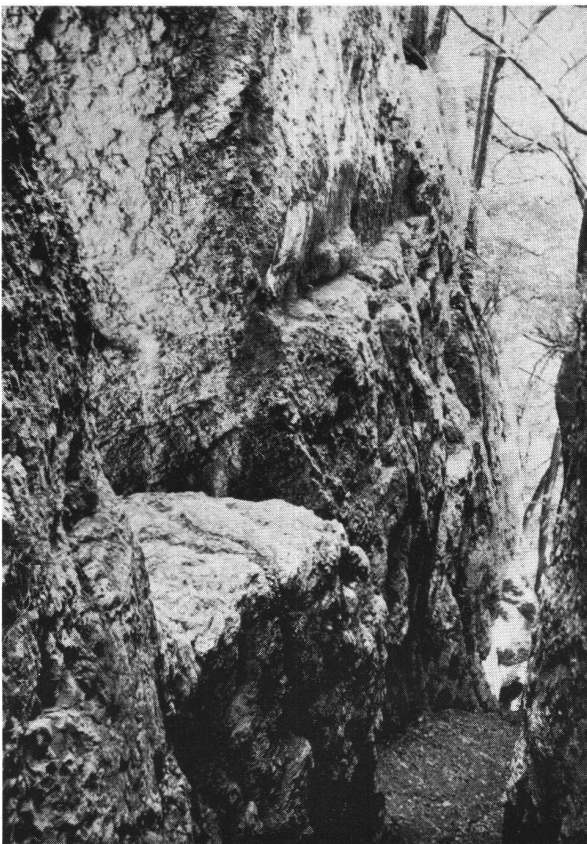
Aesch/Bärenfels BE. Ausgehauene Balkenlager.
