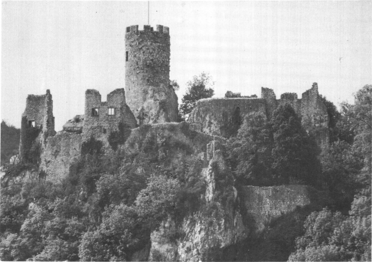
Neu-Falkenstein SO. Ansicht von Süden.
