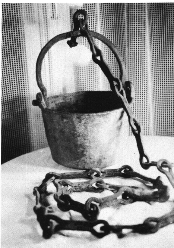
Einer der beiden Kupferkessel mit Eisenkette. Der Kessel ist inwendig verzinkt.
