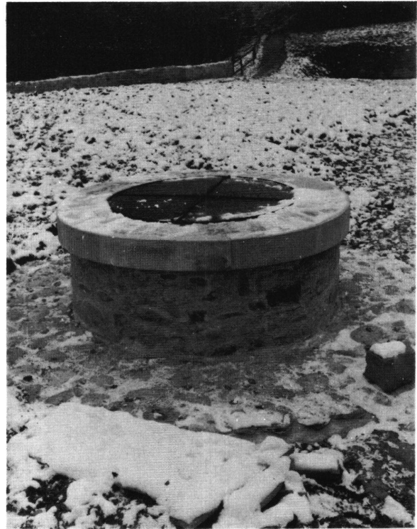
Friedberg-Meilen. Der restaurierte Brunnenkranz mit den Abdeckplatten und eingelassenem Schutzgitter.
