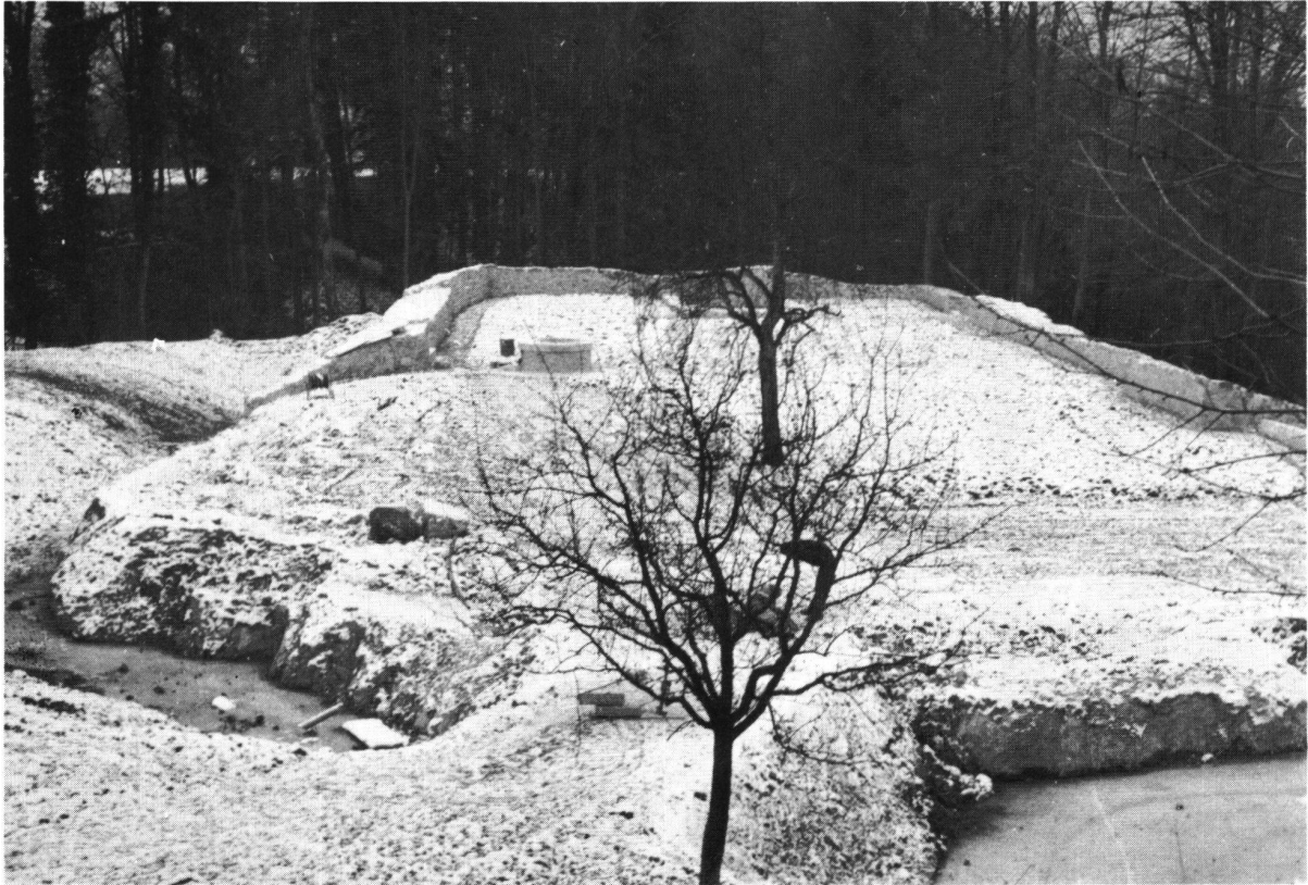
Ansicht der Anlage von Norden nach Beendigung der Grabarbeiten.
