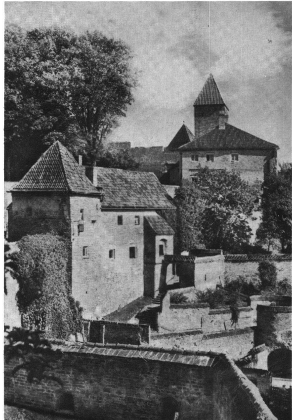
Landshut/Isar, Wehranlage der Burg Trausnitz.
