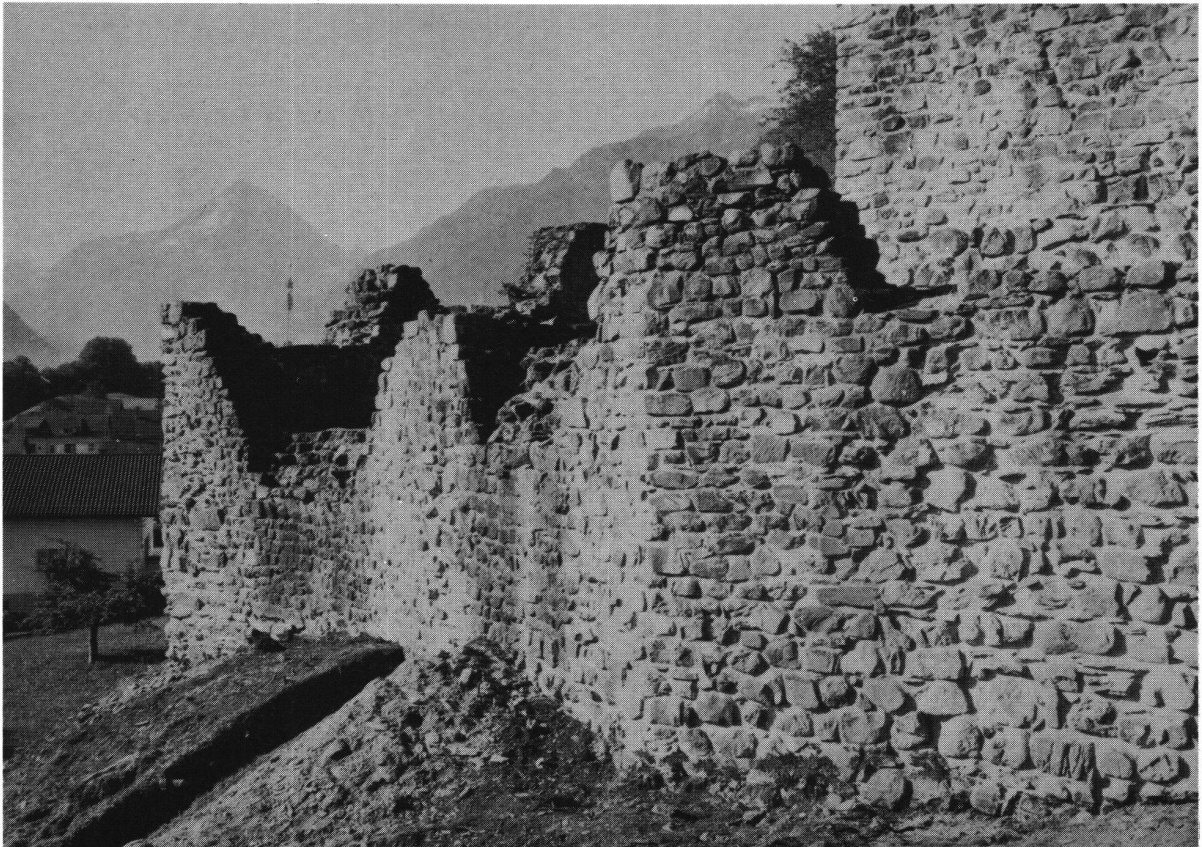
Attinghausen, Ringmauer, Blick gegen S.
