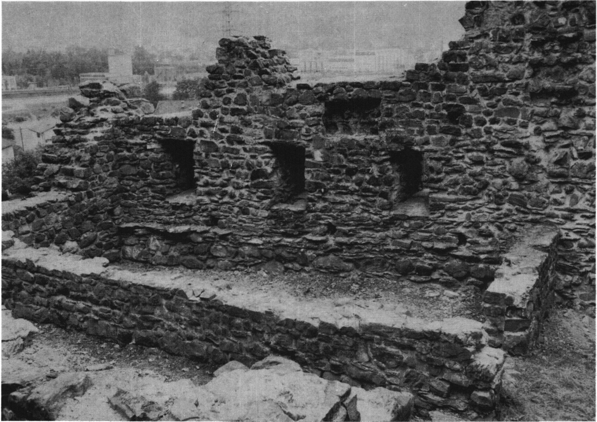
Attinghausen, Südtrakt. Blick gegen SE.
