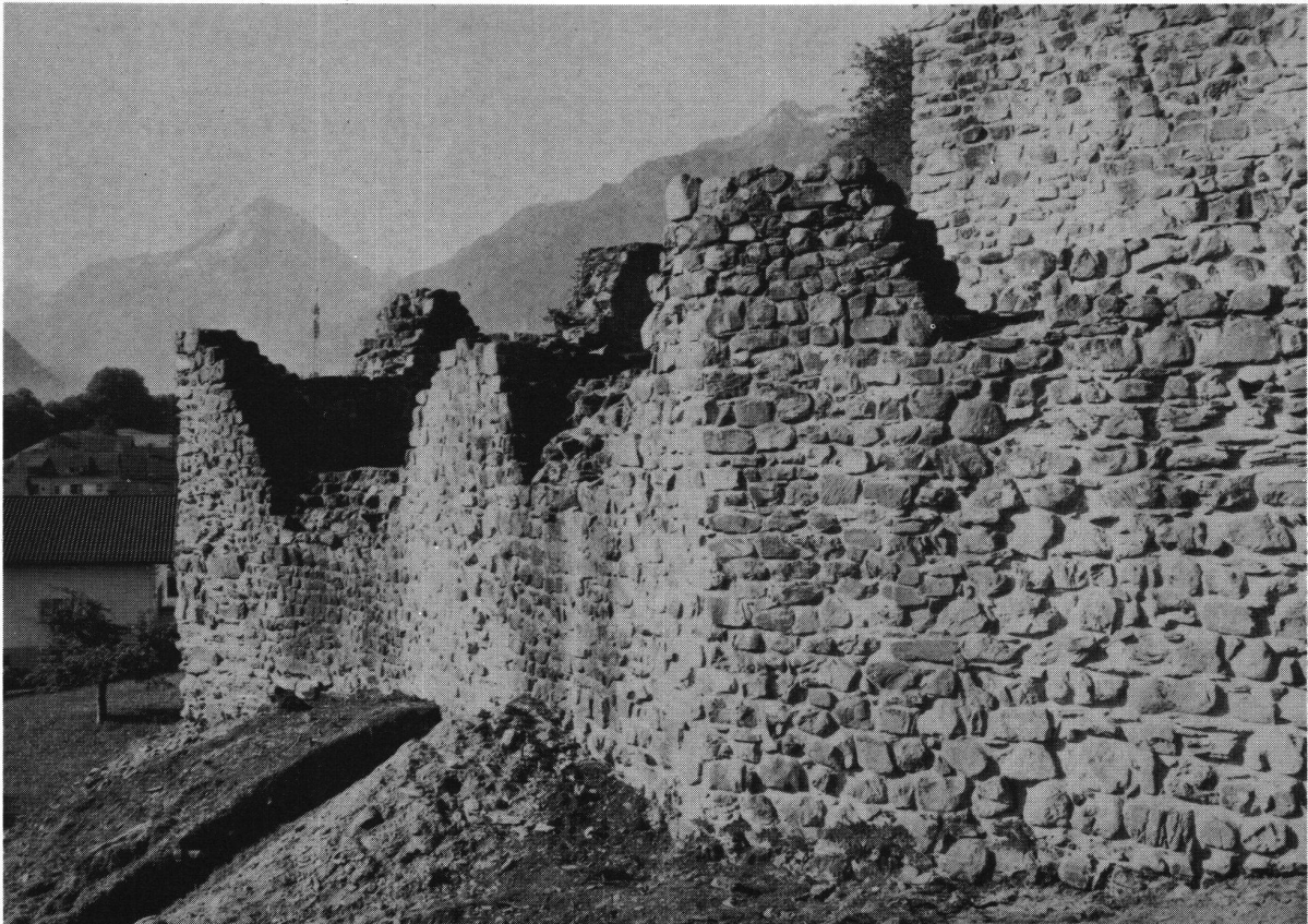
Attinghausen, Ringmauer, Blick gegen S.
