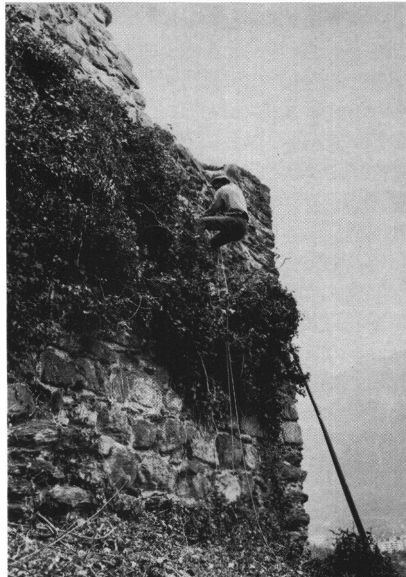
Attinghausen, Entfernung des Efeus an der Südfassade.
