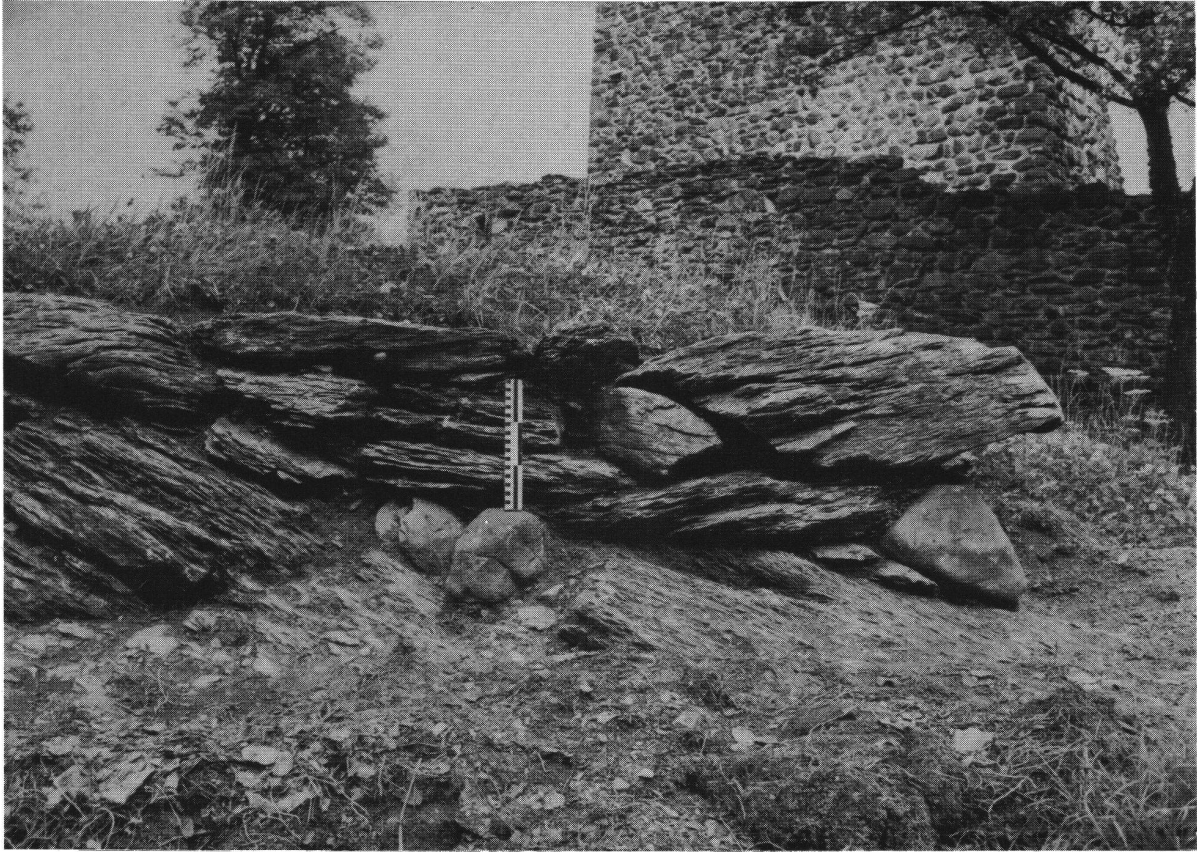
Attinghausen, zur Vorburg gehöriges Ringmauerfragment. Im Hintergrund Kernburg.
