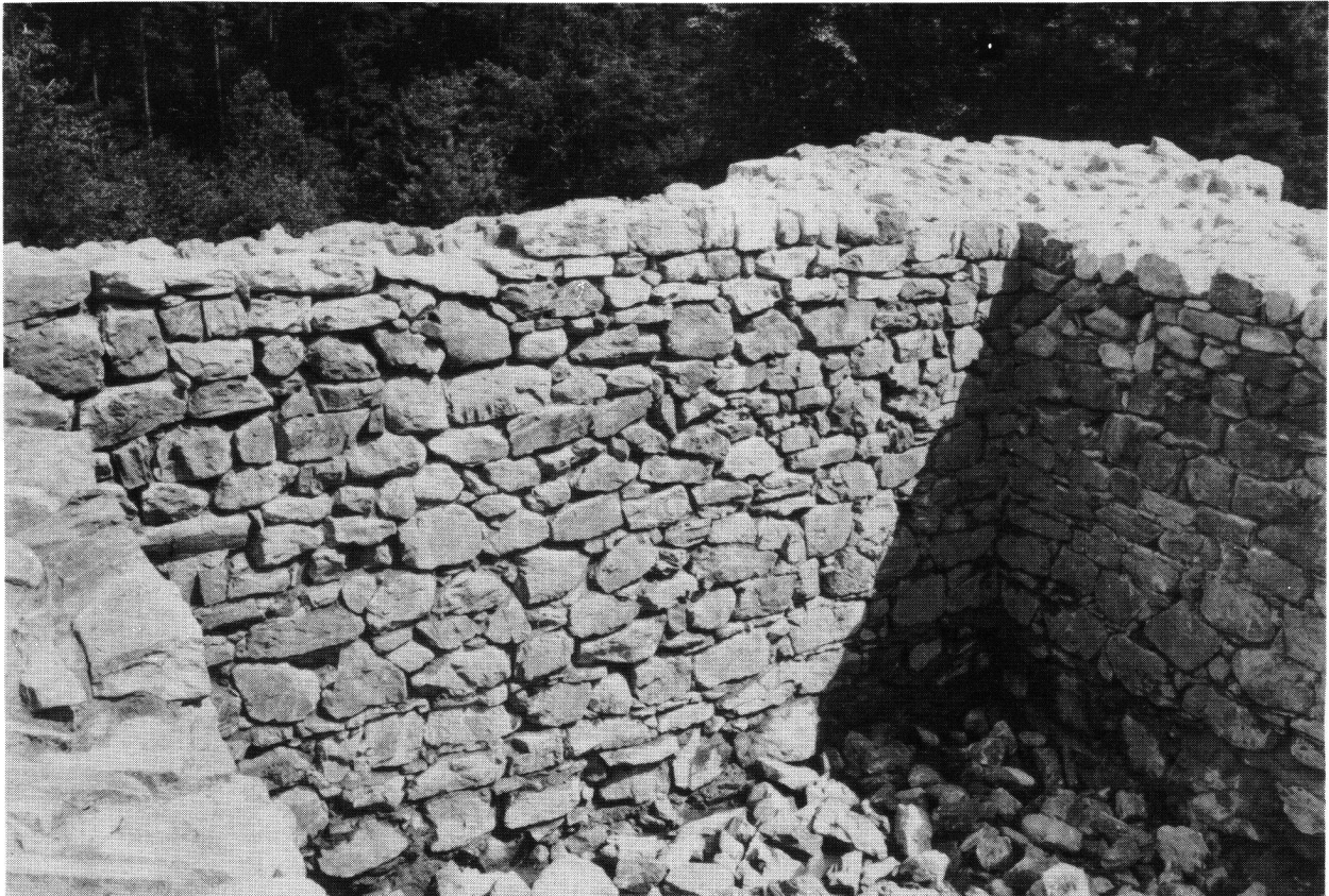
Zwing Uri UR. Inneres des Turmes nach der Konservierung, Blick gegen NE.
