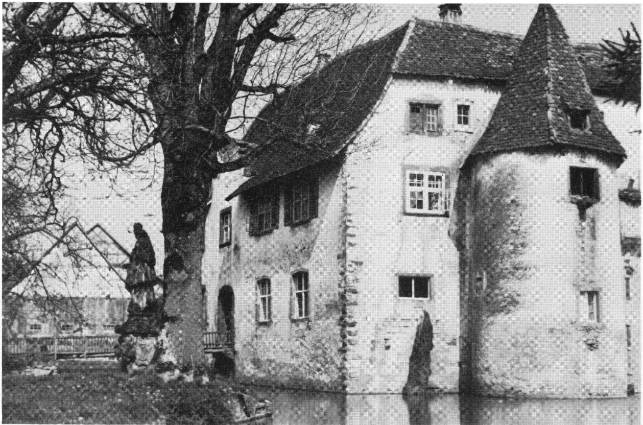
Wasserschloss Inzlingen, vor der Restaurierung.
