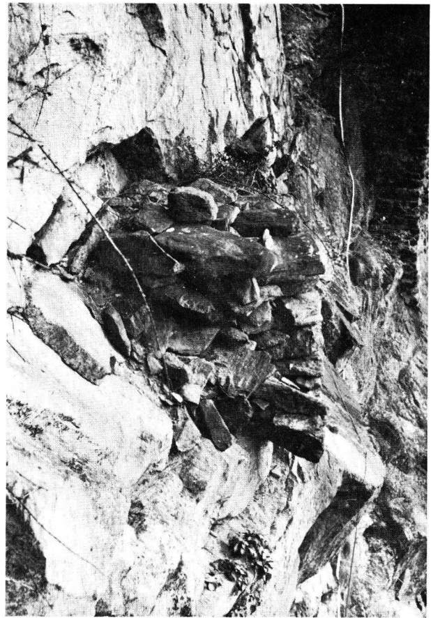
Malvaglia, casa dei pagani, der Mauerrest M2 von Osten. Der Mörtel ist fast vollständig ausgewaschen.
