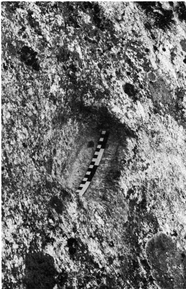
Malvaglia, casa dei pagani, Auflager eines Gerüstpfostens. Talseitig wurde vom Fels ein kleiner Wulst stehen gelassen, der ein Ausrutschen des Pfostens verhinderte.
