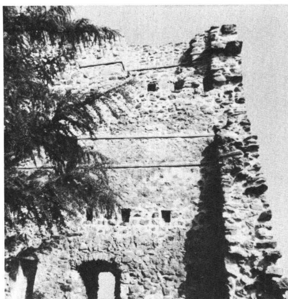
Wartenstein. Eingesetzte Täferlatten und Sitzbankunterlagen
