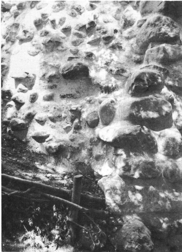
Steinerburg. Mauerhaupt und Füllung nach der Restaurierung. Photo Boari
