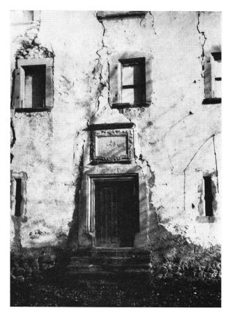
Eingangspartie des Herrenhauses mit Wappentafel. Links und rechts Schlüsselscharten und von Brand stammende Risse.
