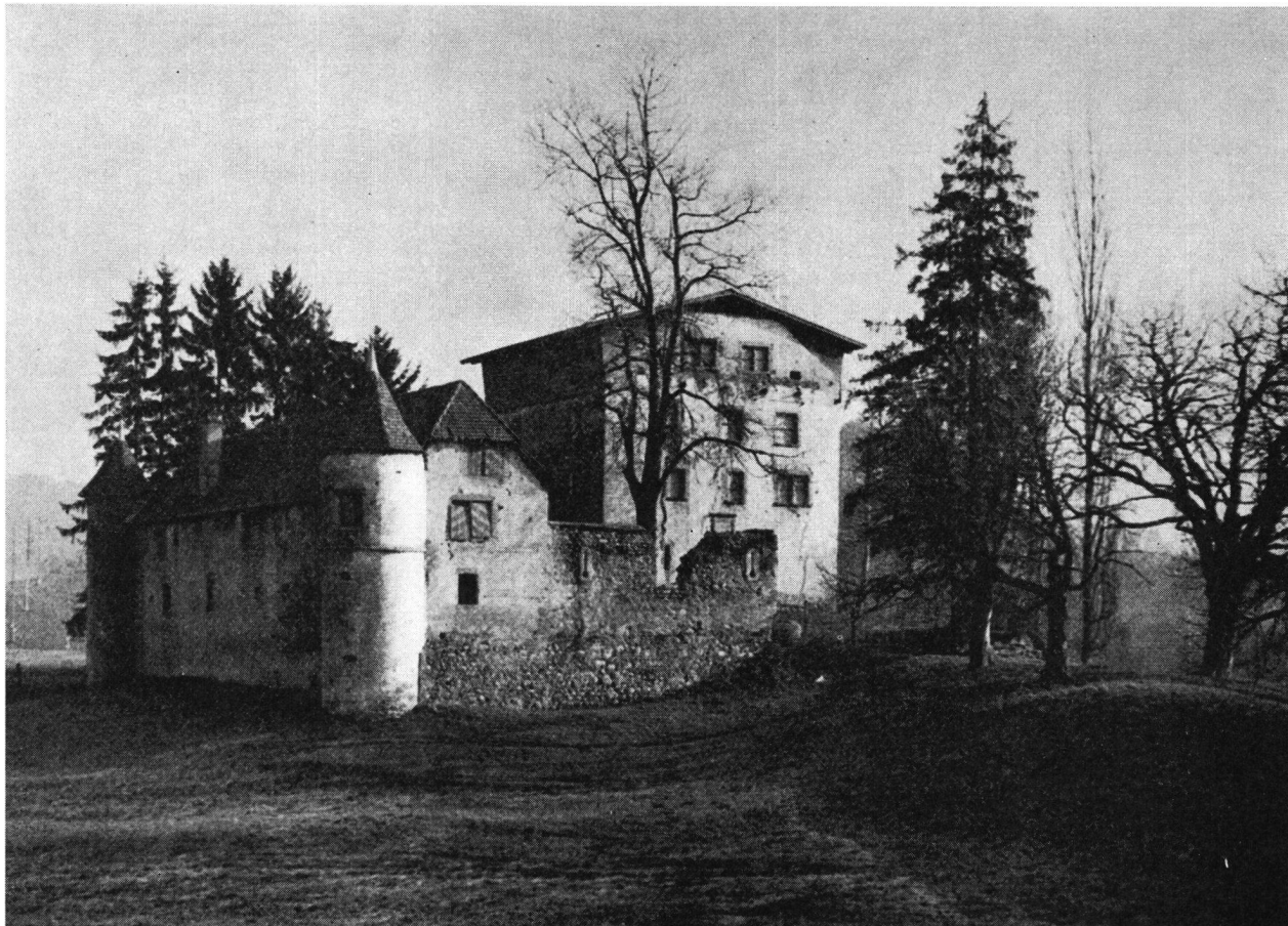
Schloss Wyher bei Ettiswil, Kanton Luzern. Ansicht von Südwesten, links Ökonomiegebäude mit zwei runden Ecktürmen, teilweise abgebrochene Wehrmauer mit Einfahrt, dahinter das Herrenhaus mit Notdach. Vorgelände ehemals Weiher.
