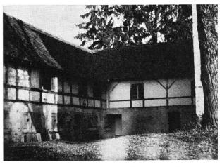
Hofansicht des Ökonomiegebäudes. Unten links Wohnung mit Schmiede, darüber Gesindekammern mit hofseitigem Korridor, rechts Zwischenbau mit Stall und Laube.
