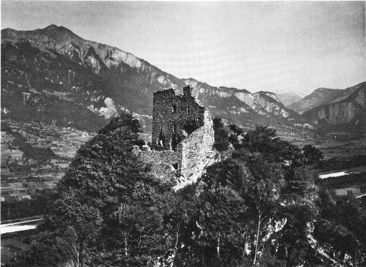
Ruine Wartenstein SG. Die neuen Restaurierungsarbeiten erfolgen unter finanzieller Mitbeteiligung des SBV.
