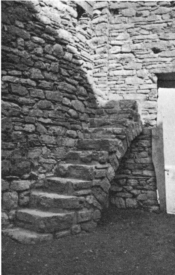
Unspunnen bei Interlaken BE Burgruine. Die anlässlich der Restaurierungsarbeiten rekonstruierte Treppe vom oberen Palas zum Rundturm.
