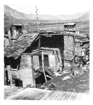
Saillon VS ...von der Rückseite besehen ist der Schaden um einiges schlimmer. Die Dachpartie mußte inzwischen wegen Einsturzgefahr abgetragen werden.
