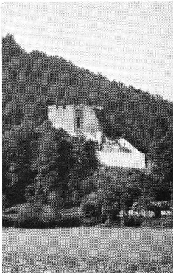
Unspunnen bei Interlaken BE Burgruine. Ansicht von Südwesten. Links der obere Palas, rechts der Hauptturm (Rundturm), darunter die ausgedehnten Reste des nunmehr konsolidierten unteren Palas und des Burghofes.
