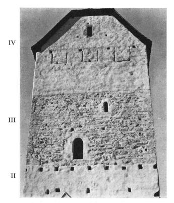
Der restaurierte Bergfried von Sargans, Ostseite. Von unten nach oben: II = Tuffzone mit neuem «Limonitputz» und Balkenlöchern der ehemaligen Wehrlaube; III = Malmkalkband mit orig. Fugenstrichmörtel, im oberen Teil ergänzt bis zu den vermauerten Zinnen; IV = Späterer Dachgiebel.
