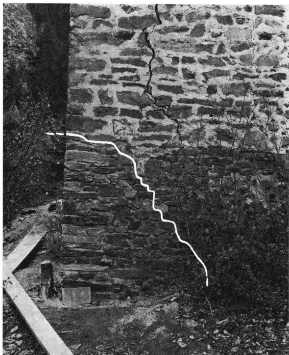
Hohenrätien GR. Burgruine. Südostturm. Unter dem weißen Strich die eingemauerte Ecke. Hier war der Einsturz der ganzen Ostwand zu befürchten (man beachte den klaffenden Riß). Die Fugen werden im Frühjahr mit Kalkmörtel ausgestrichen, um dem ergänzten Mauerwerk den gleichen Farbton zu geben. Aufnahme Oktober 1970. (Die weißen Linien sind am Objekt markiert)
