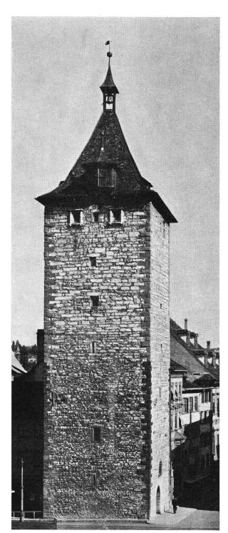
Schaffhausen Obertorturm. Ehemals Wohnturm der Fridbolten. Nach Übergang in den Besitz der Stadt, 1461, wurde der Bau bis 1513 zur heutigen Höhe von 10 Stockwerken aufgeführt (47 Meter). Mauerstärke im Erdgeschoß 1,80 Meter. Die Fundamente gehen bis 6 Meter tief in den Boden. Glocke von 1598. Bis 1845 diente der Obertorturm einem Feuerwächter als Behausung.
