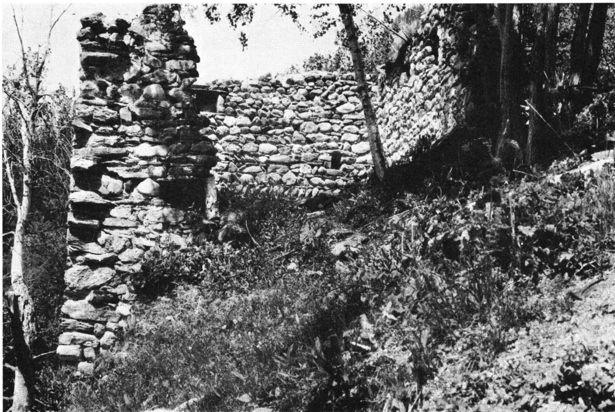
Haselstein GR. Burgruine. Blick in den nördlichen Palasteil von Süden. Im dritten Geschos sind drei Wandnischen sowie das Ausgußloch eines Schüttsteins sichtbar. Links im Bild die SW-Ecke mit den vorstehenden Bindern für den Anbau des südlichen Palasteils. Aufnahme Oktober 1970.
