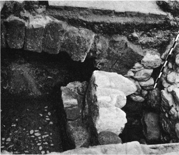
Zug Burg. Detail der Steinbrücke mit späterer Bollensteinpflasterung und Verstärkung des einen Widerlagers. Ansicht von Südosten. Der Wassergraben, über den die Brücke führte, wurde bereits um die Mitte des 16. Jahrhunderts zugeschüttet.
