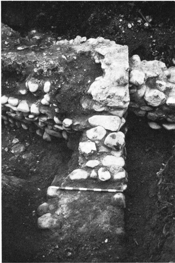
Abb. 4 Oberbüren SG. Grabung «Turm zu Büren». Südöstliche Turmecke. Ansicht von Westen.
