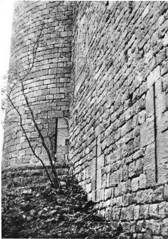
Landsberg bei Schlettstadt, Unterelsaß. Vorburg mit Flankenturm aus dem Ende des 13. oder Anfang des 14. Jahrhunderts. Im Vordergrund drei Schießscharten für Bogen- und Armbrustschützen.
