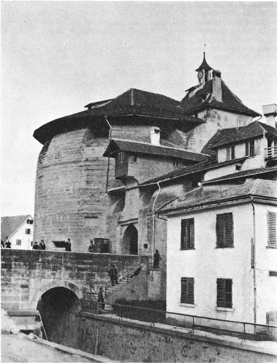
Zürich Rennwegbollwerk. Errichtet 1521 bis 1524 von Baumeister Johann Georg Göldli. Abgebrochen 1865. Frühestes Beispiel in der Schweiz des aus Italien übernommenen Typus einer Konstruktion, welche bereits schweren Pulverwaffen zu trotzen hatte. Aufnahme kurz vor dem Abbruch 1865.
