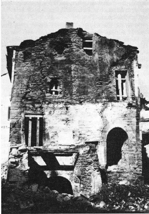
Brig VS Salzhof. Südfassade des neu entdeckten, mittelalterlichen Wohnturmes mit Rundbogentüre.
