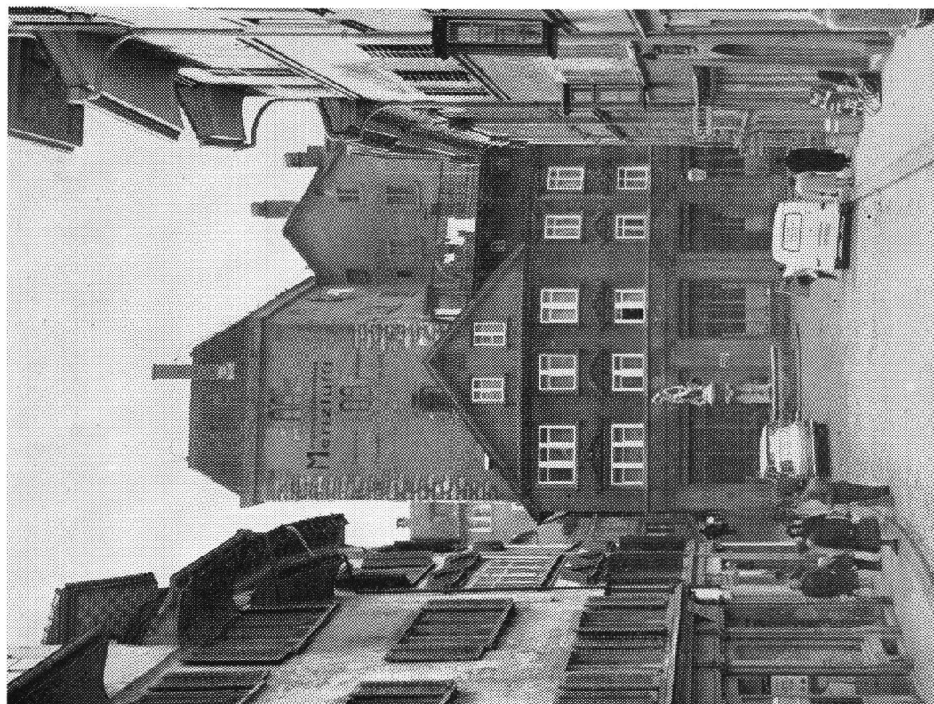
Zürich, Grimmenturm. Die beiden Bilder veranschaulichen uns ein eindrückliches Beispiel aus der Tätigkeit der städtischen Denkmalpflege. Diesem typischen Adelsturm, der erst vor rund 100 Jahren bis zur Unkenntlichkeit verbaut wurde, konnte in einer gelungenen Rekonstruktion 1964–1966 das frühere Aussehen zurückgegeben werden. Alte Stiche und Zeichnungen bildeten die Grundlagedokumente zur Planung. Die Entwürfe zur künstlerischen Ausstattung wie Zifferblatt, Glocke mit Inschrift, Wetterfahne usw. schuf der bekannte Zürcher Grafiker Ernst Keller.
