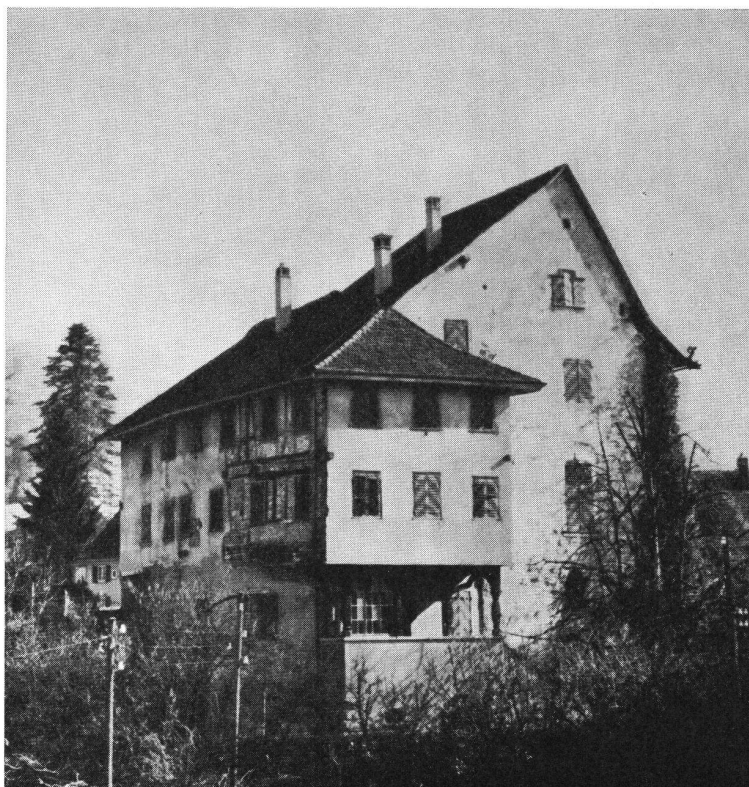
Zug Burg. Ansicht von Norden. Der Palas (links) wurde im 16. Jh. auf dem Mauerwerk eines früheren Baues in vorkragender Konstruktion aufgestockt. Rechts Bergfried mit später aufgesetztem Giebel. Seine ursprüngliche Höhe reichte bis zum Kranzgesimse.
