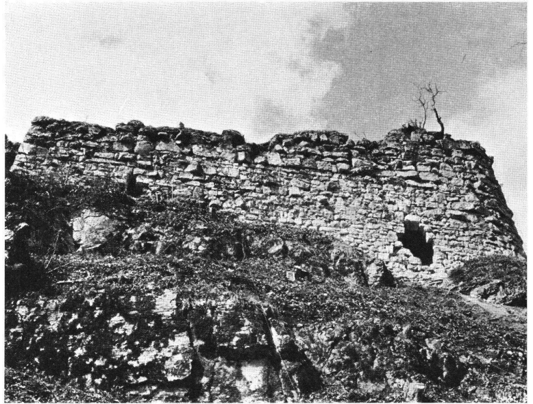
Abb. 1 Wartburg, Wohnturm von Osten.
