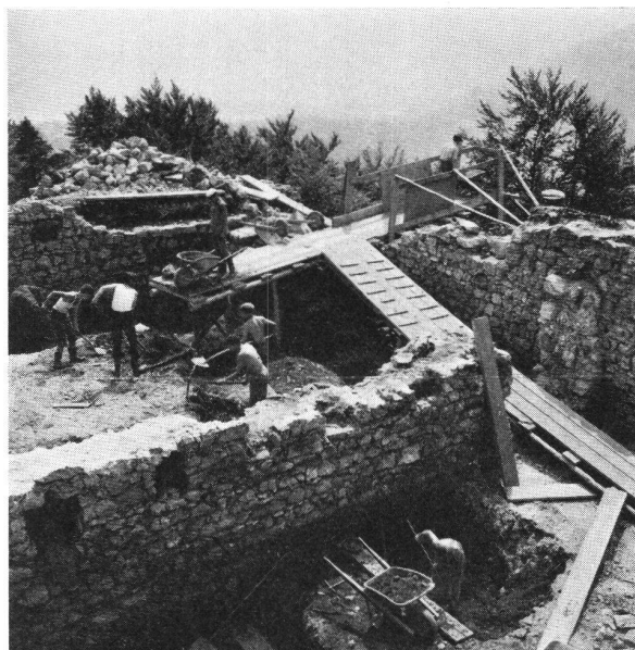
Wartburg, Aushub der Schuttmassen.
