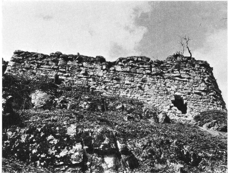
Abb. 1 Wartburg, Wohnturm von Osten.
