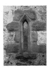
Gotisches Fenster, Ecken mit Kantenschlag ausgebildet
