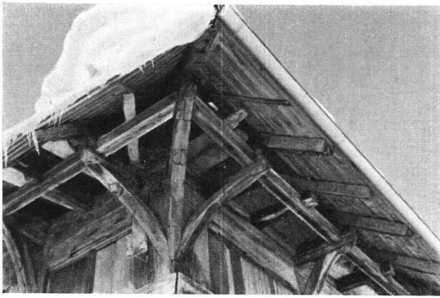
«Heidenhaus» Großschneit bei Köniz BE. Geschwungene Holzbügel mit Wappenformen (vgl. Text). Eine ähnliche Wappenform findet sich an einem mindestens ins 16. Jahrhundert zurückreichenden Speicher in Ried bei Kerzers FR. Holzbügel stützen auch das vorkragende Dach des Pfarrhauses in Zweisimmen (wahrscheinlich 15. Jh., wiederaufgebaut nach dem Brand 1940). – Es ist damit zu rechnen, daß mittelalterliche Bautraditionen in «verbaueter» Form weiterleben, vor allem von den festen Häusern und ritterlichen Meierhöfen her. In Großschneit weisen weitere, heute entfernte gotische Holzteile nach H. Türlin ins 15. Jahrhundert.
