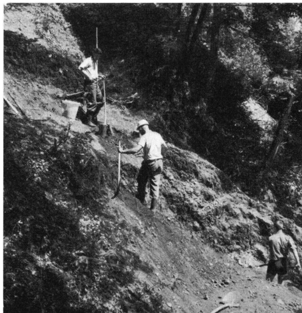
Löwenburg BE Hartes Arbeiten in der steilen Schutthalde
