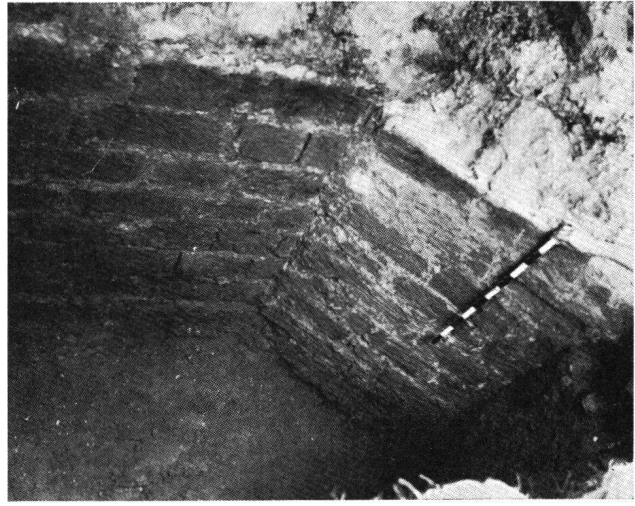
Englisberg Anstoß der südlichen Schildmauer an den Turm in Schnitt 7
