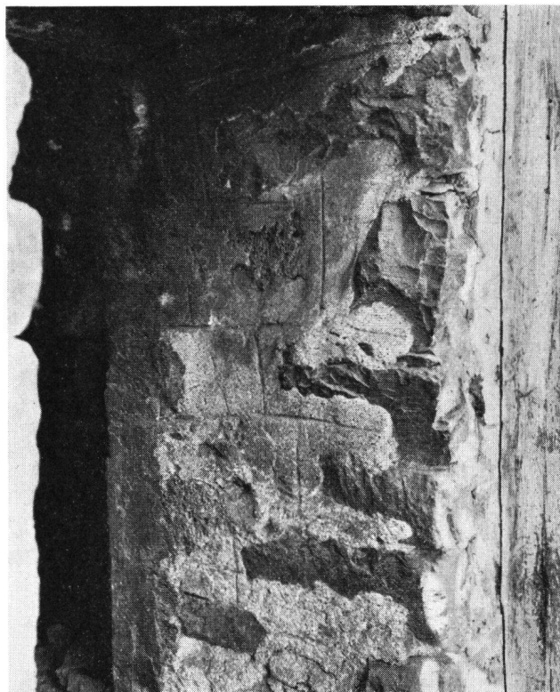
Bürglen UR Eingang zum Turm 3 mit mittelalterlichem Fugenstrich
